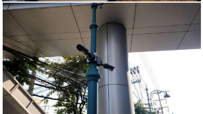
รูปที่ 41 ระบบโทรทัศน์วงจรปิด (CCTV System)
