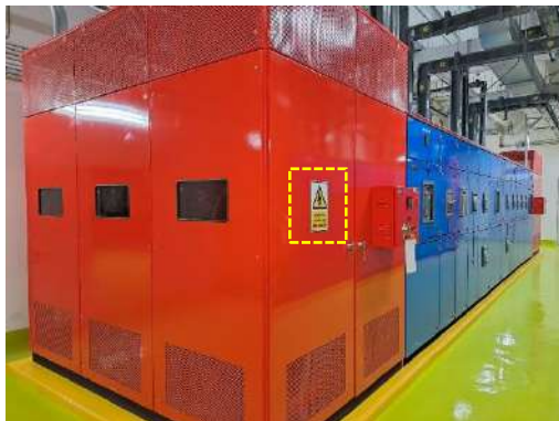
รูปที่ 21 ป้ายเตือนอันตรายบริเวณห้องหม้อแปลงไฟฟ้า
